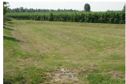
Bestaande wadi voor waterberging, retentie en infiltratie in combinatie met versterking biodiversiteit.
