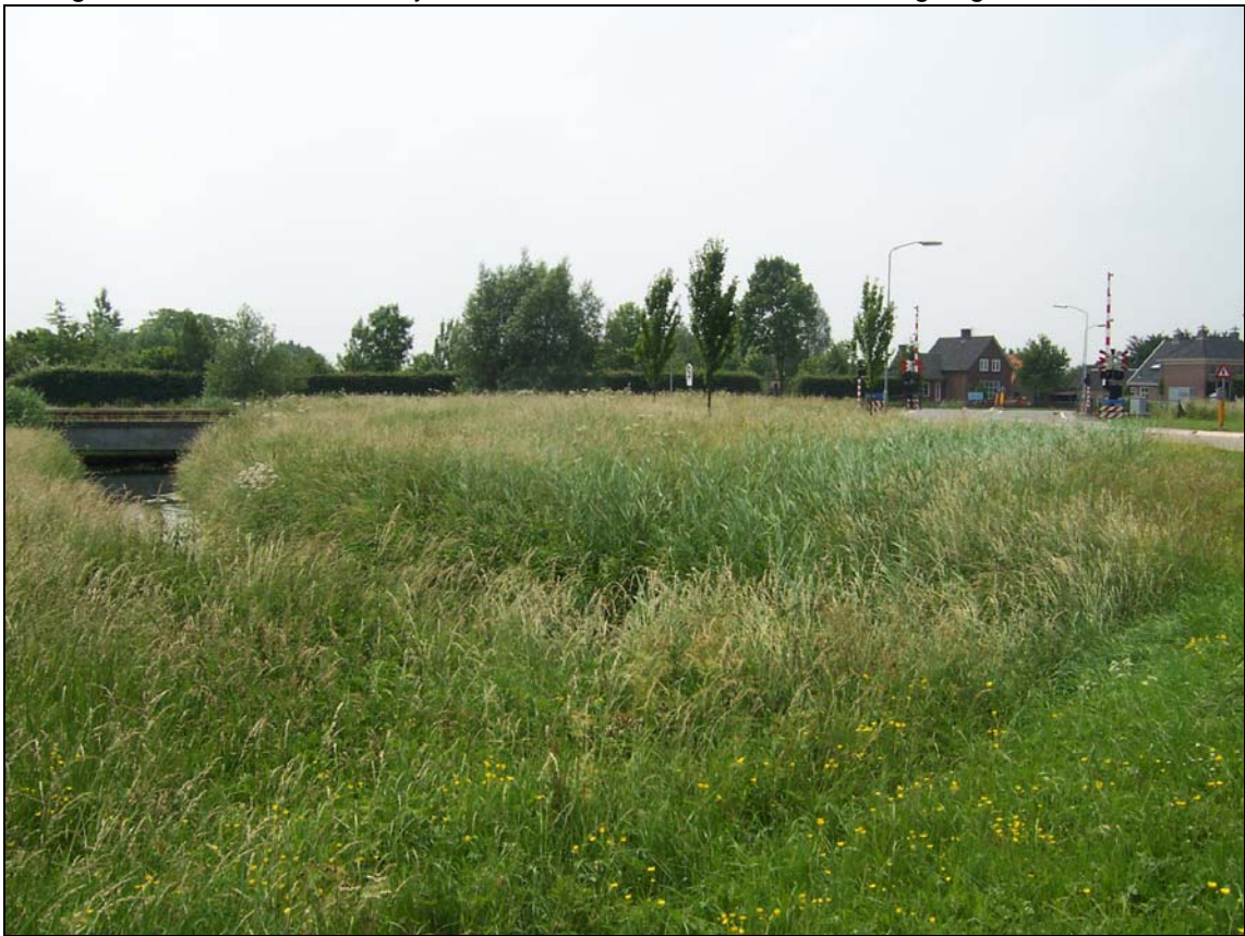
Links op de foto de duiker onder het spoor. Rechts de spoorwegovergang.
