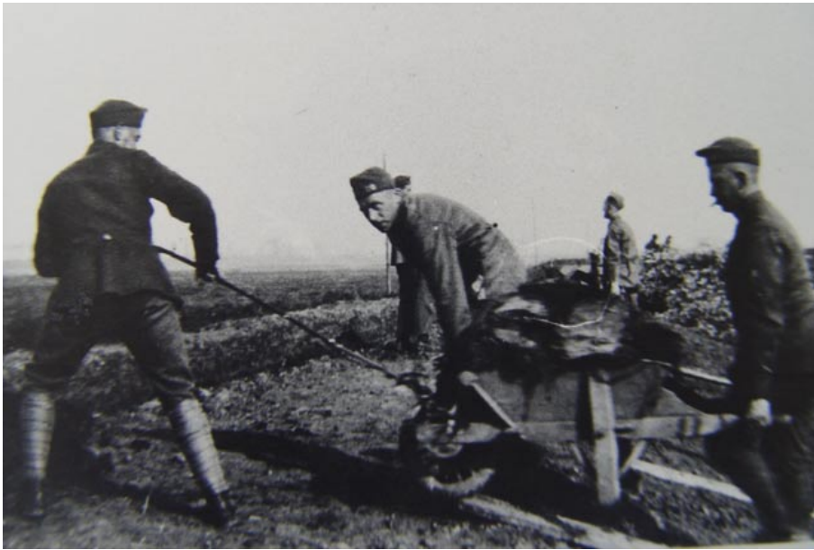
Afbeelding 10: Het werk aan de liniedijk.
