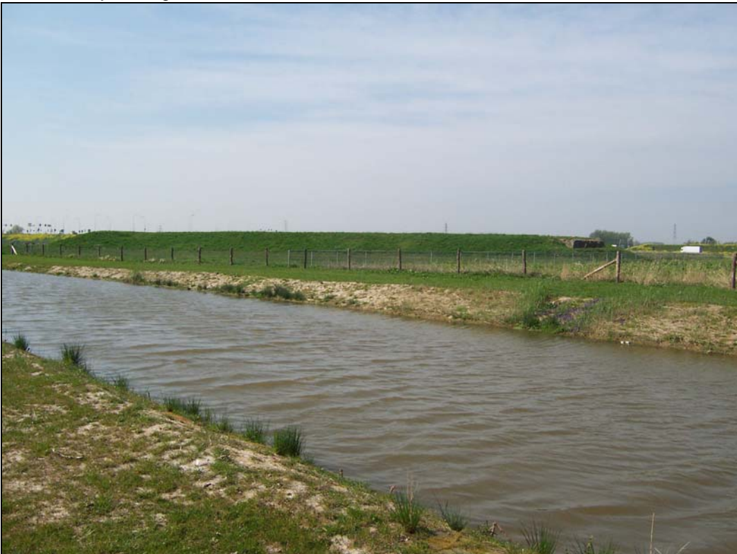
Het redan met daarin restanten van een G-kazemat. Op de voorgrond de Linge.
