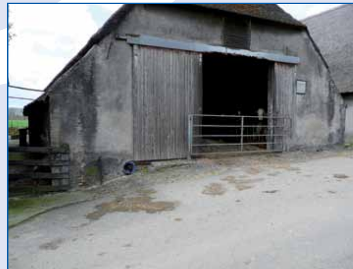
Huidige situatie schuur. Het hoogteverschil is duidelijk zichtbaar
